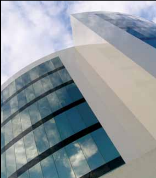
■ Torre Lázaro Cárdenas
