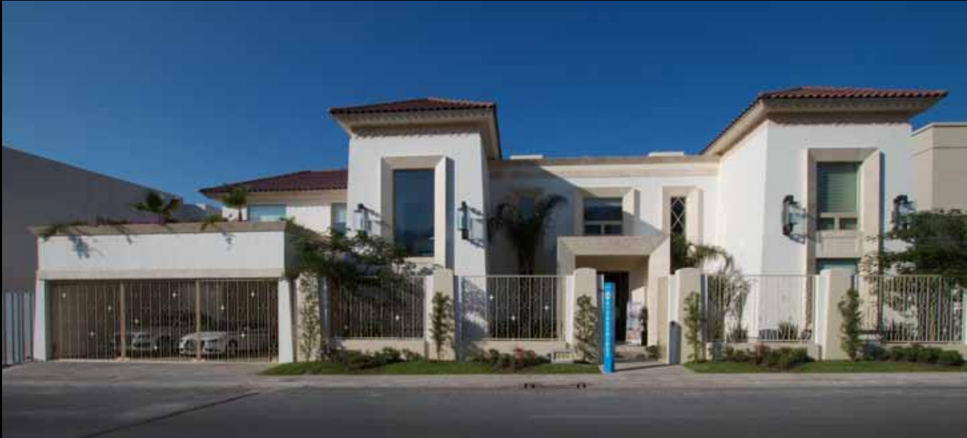
■ Casa Sorteó Tec, Monterrey
